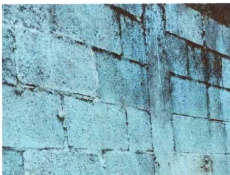
Foto 11: Reparación muro perimetral de block
