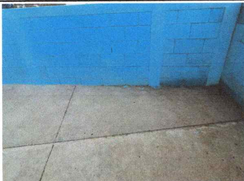
Foto 13: Reparación de planchas de concreto de patio
