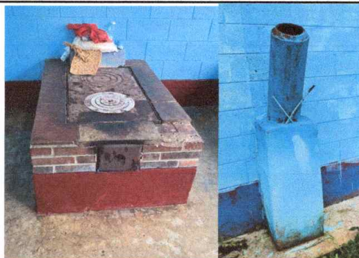
Foto 2: Sustitución de estufa rural (más azulejo)
