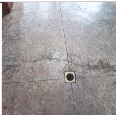
Foto 3: Sustitución de piso de cemento líquido por piso cerámico (más nivelación)
