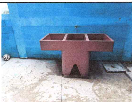
Foto 5: Sustitución de pila de cemento de dos lavaderos tipo tanque (más azulejo)
