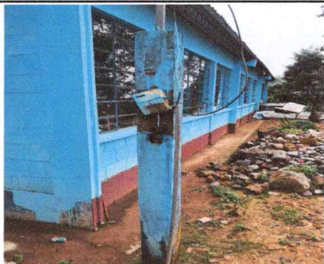
Foto1: Reparación de cableado eléctrico
